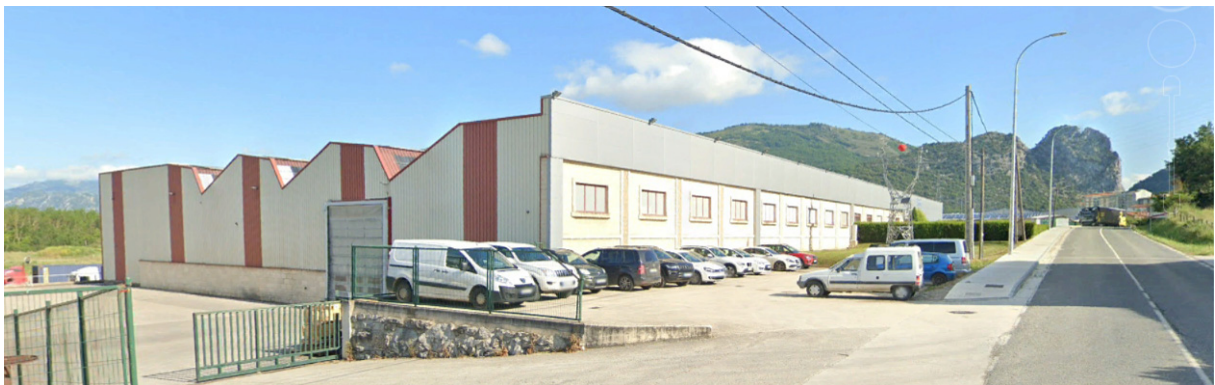
Vista general de la edificación desde la carretera NA-7010
